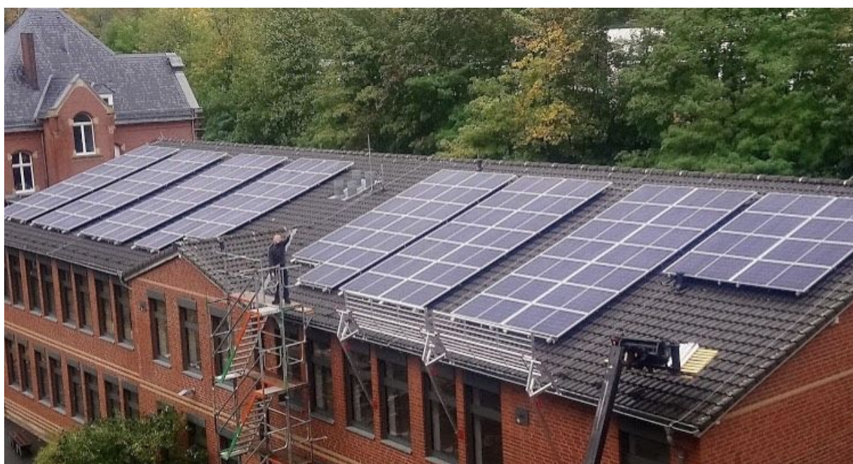
Fertig montierte Module am 17.10.19
